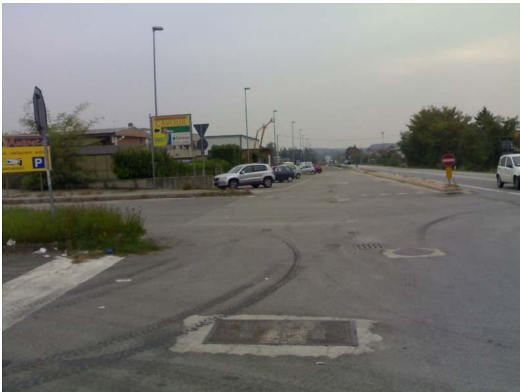
Foto n.1 Incrocio con pozzetto fognatura esistente
