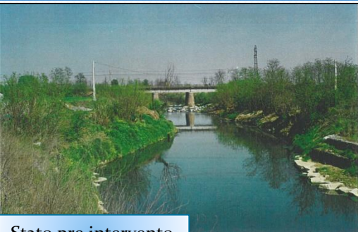
Stato pre intervento
