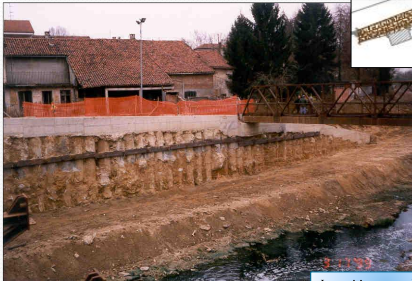
Lavori in corso d'opera
